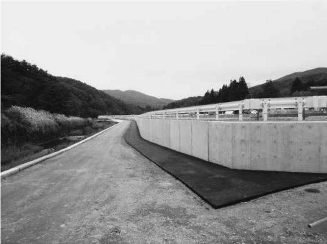
写真 2 飯館村長泥（帰還困難区域）での汚染土壌を活用した実証事業による圍場整備。比曾川沿いに膨大な擁壁が造られ、その内部に汚染土壌が1m以上堆積している。実証事業として何十年とこの擁壁からの放射性物質の流出を防止することにもなる。
